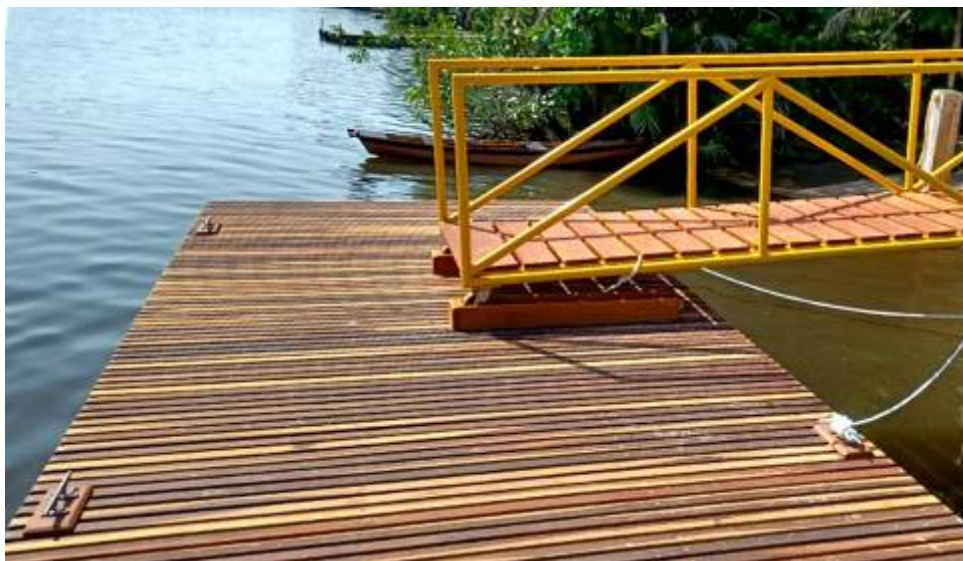
Exemplo do piso de madeira do píer flutuante.
