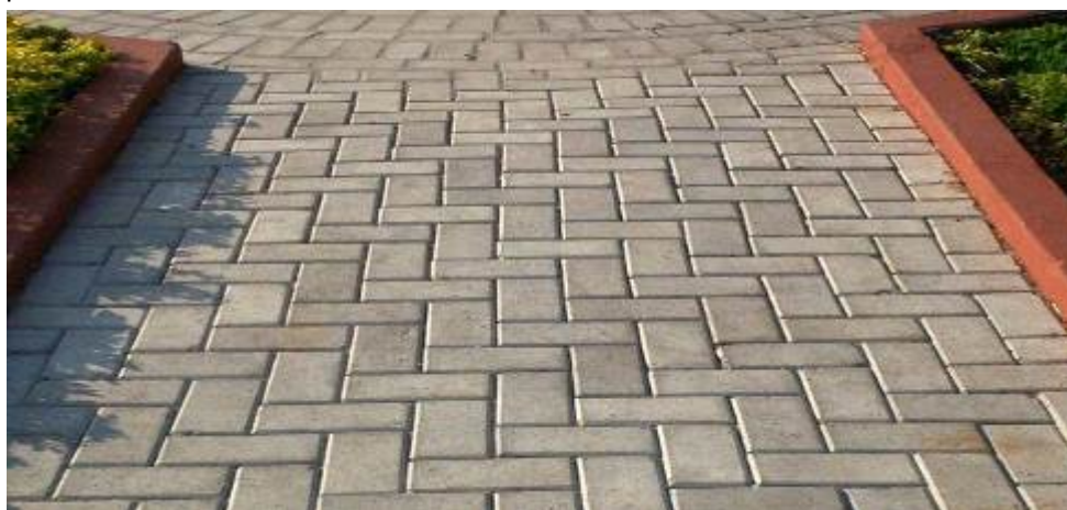
Exemplo de piso intertravado em concreto. Será aplicado no entorno da edificação do (conforme indicação do projeto).
