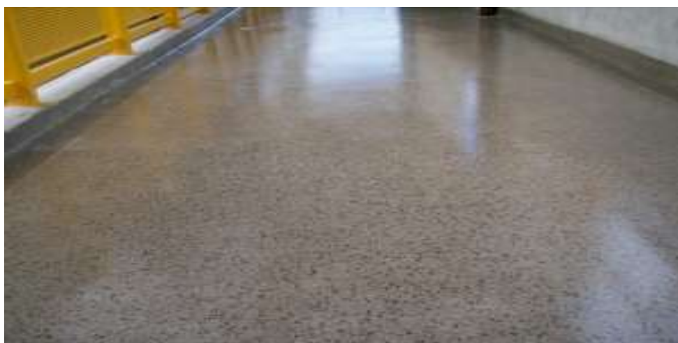
Exemplo de piso em granilite. Será aplicado no interior da edificação.
