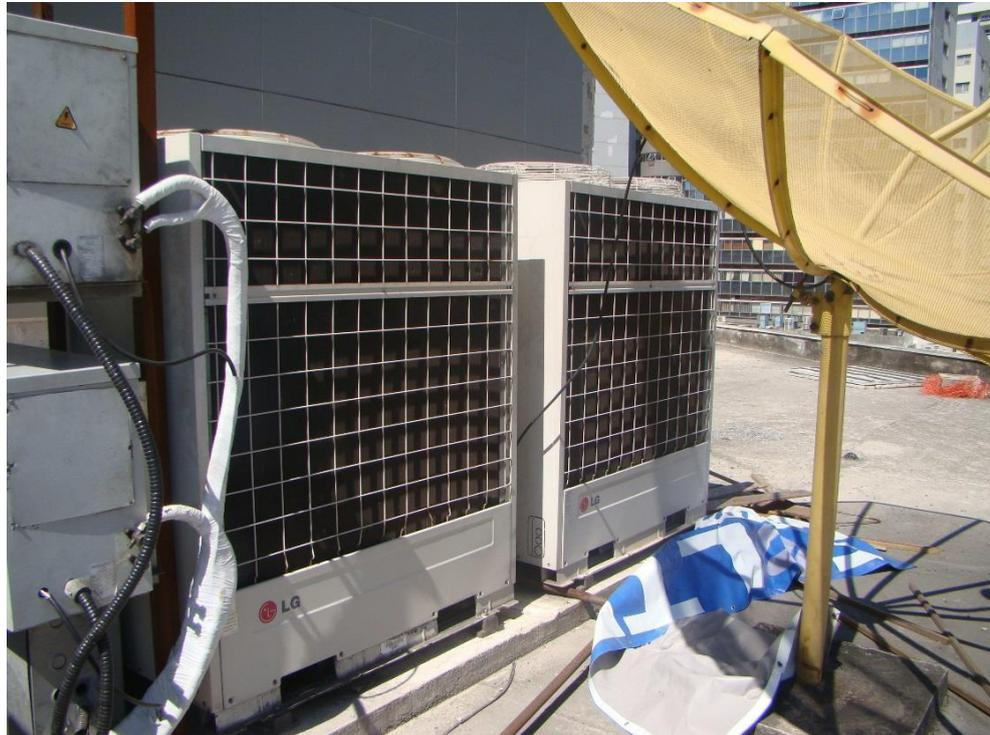
**Figura 1 - Unidades Condensadoras LG**
