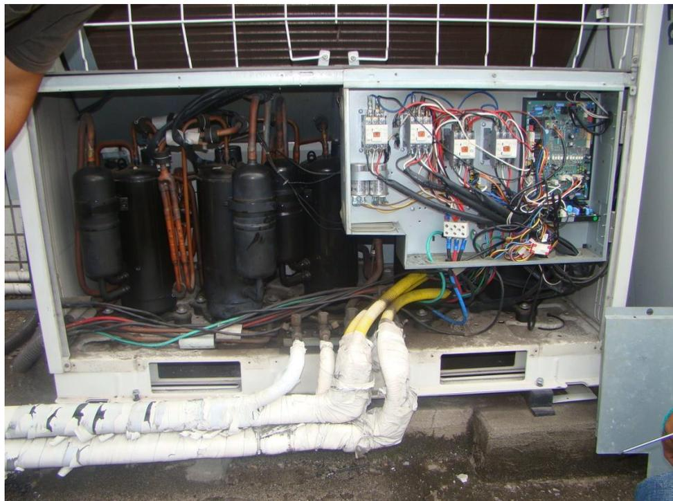
**Figura 2 - Interior Unidade Condensadora LG**
