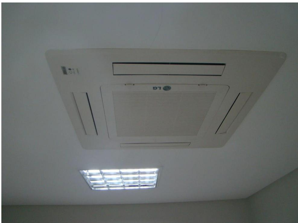
**Figura 3 – Unidade Evaporadora LG (Fechada)**
