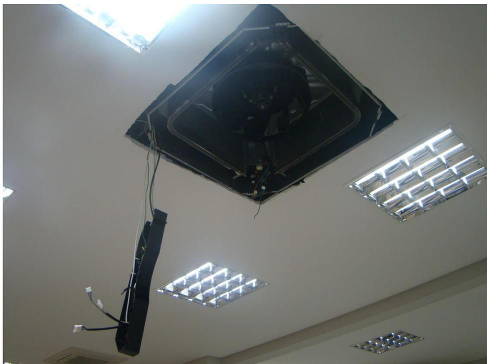
**Figura 6 – Desmonte Evaporadora LG para Manutenção Preventiva e Corretiva**
